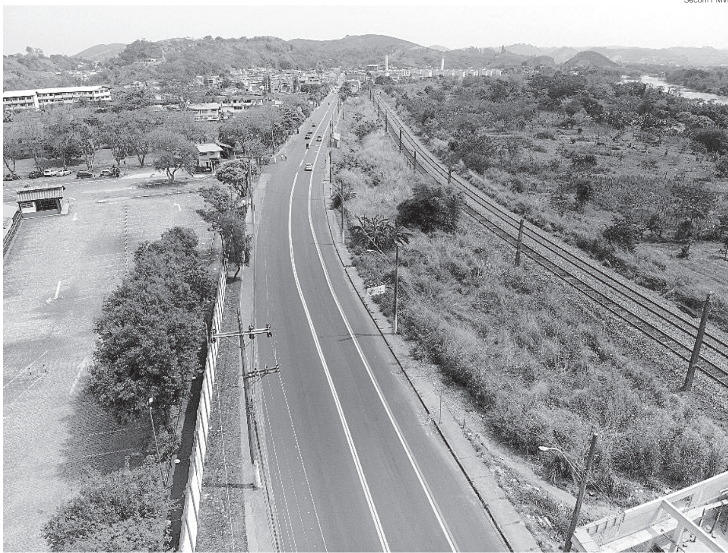
Avenida Paulo Erlei, em Três Poços, recebe nova pintura
